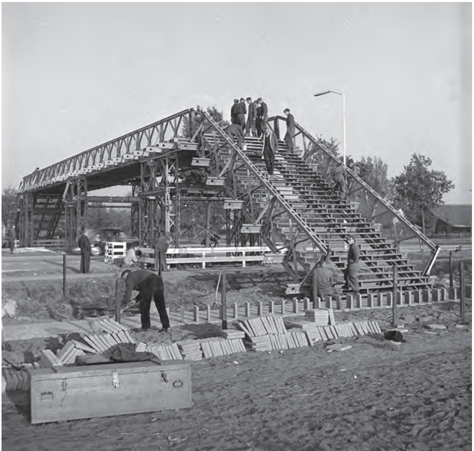
Gemeentewerkers leggen ondertussen het tegelpad naar de brug, 20 oktober 1965 (Foto Visie/Frans van Mierlo, collectie RHC, Eindhoven).
