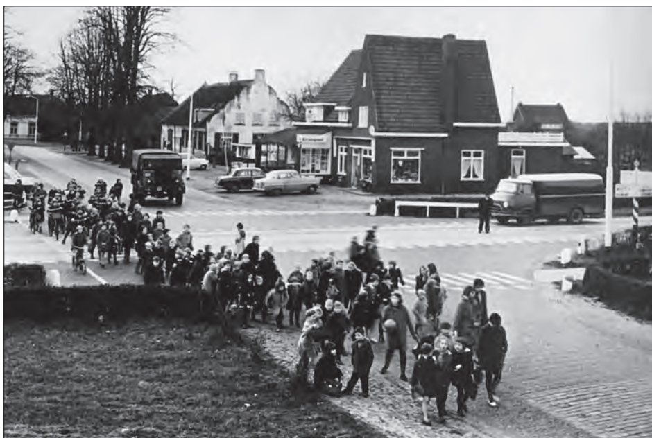
Een overzicht van de gevaarlijke situatie op het kruispunt tot de aanleg van de Baileybrug, foto vermoedelijk uit 1965 (collectie J. Biemans, 's-Hertogenbosch).
