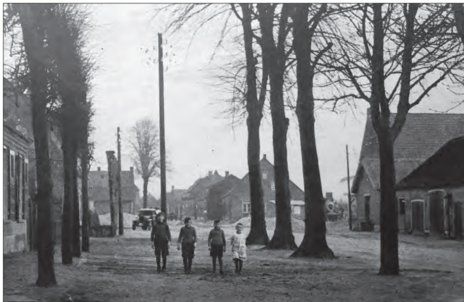
Gezicht vanuit de Kerkstraat richting de Stationsstraat. Midden op de foto is de aanleg van de nieuwe rijksweg in volle gang, 1937 (collectie J. Biemans, 's-Hertogenbosch).
